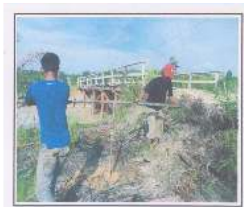
Gambar 4. Penyondiran di Lokasi Jembatan
