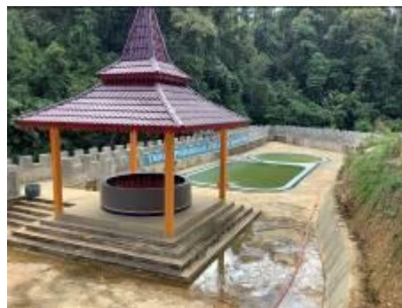
Gambar 3. Infrastruktur yang ada di objek wisata air panas
