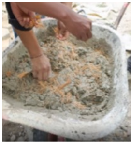
(c) Pemberian serat kelapa pada adonan mortar
