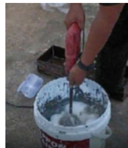
(h) Foam agent dicampurkan ke mortar
