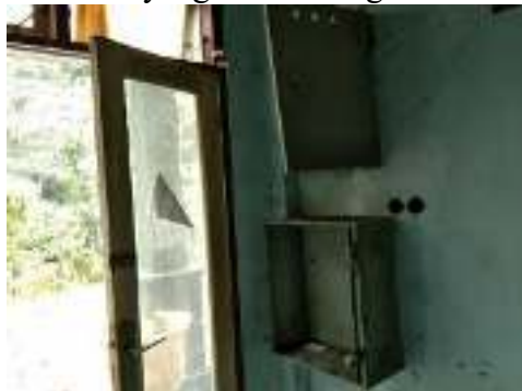
Gambar 4.12. Instalasi Papan Control listrik lantai 1
