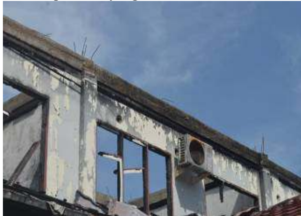
Gambar 4.16. Instalasi listrik pada Ac
