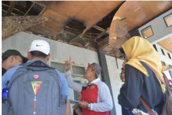
Gambar 4.15. Instalasi kabel listrik lantai 1
