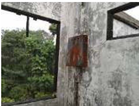
Gambar 4.13. Instalasi MCB listrik
