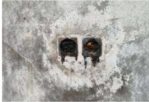
Gambar 4.14. Instalasi Stop Kontak listrik
