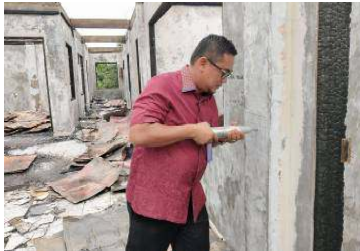
Gambar 4.11 Pengujian Hammer Test pada Kolom Lantai II
