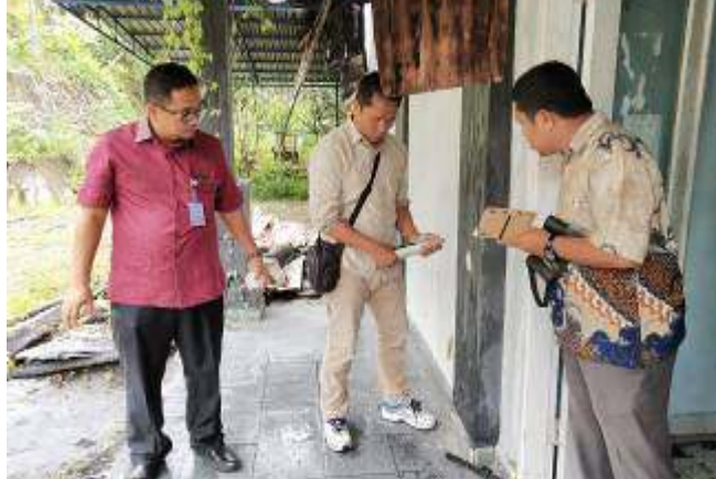
Gambar 4.10 Pengujian Hammer Test pada Kolom Lantai I
