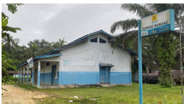
Gambar 7. pos penyedia pasokan listrik
