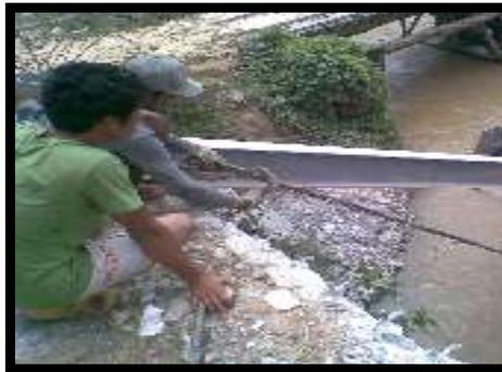
Gambar 4.13. Batang tepi bawah jembatan diikat pada setiap sisi/sudut
