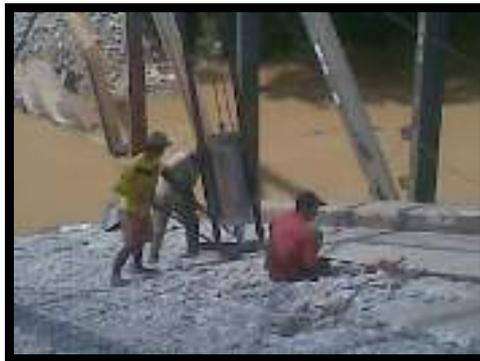
Gambar 4.7. Perangkat pengangkat *drop hammer*
