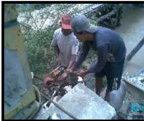
Gambar 4.10. Katrol dijepit pada abutment jembatan
