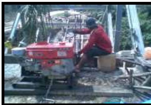
Gambar 4.8. Operator mengoperasikan alat winch
