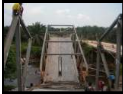
Gambar 4.4. Batang tepi atas yang akan diturunkan
