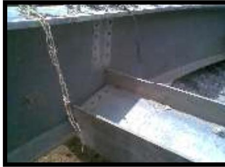
Gambar 4.9. Baut pada gelagar memanjang yang telah dilepaskan
