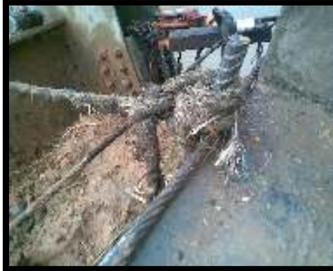
Gambar 4.12. Besi dilas pada pada tepi abutment jembatan
