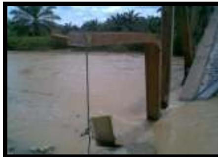
Gambar 4.6. Diagonal jembatan yang telah patah
