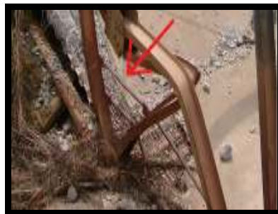
Gambar 4.1. Sandaran/pagar yang telah patah/bengkok
