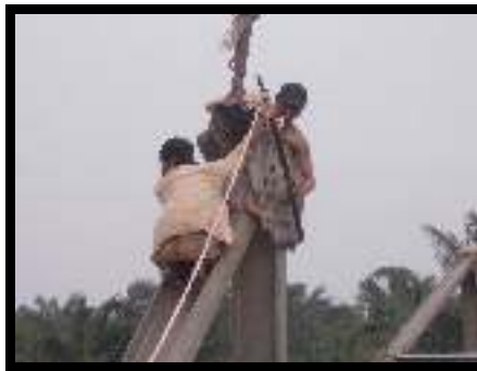
Gambar 4.5. Diagonal jembatan akan ditarik dan diturunkan
