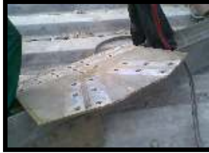
Gambar 4.2. Plat simpul yang telah dilepas
