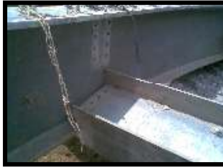
Gambar 4.9. Baut pada gelagar memanjang yang telah dilepaskan
