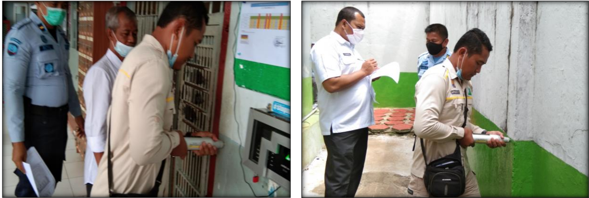
Gambar 6. Pengujian Hammer Test Pada Kolom
