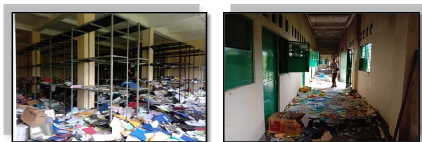
Gambar 6. Ruang 5,6,7,8 dan 9 pada gudang arsip tidak terbakar
