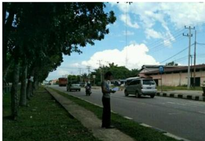
Gambar 4. Kondisi Geometrik Jalan Proklamasi
