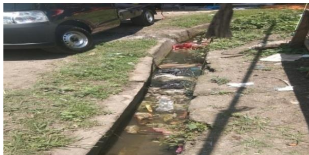
Gambar 6. Drainase di Pasar Benai
