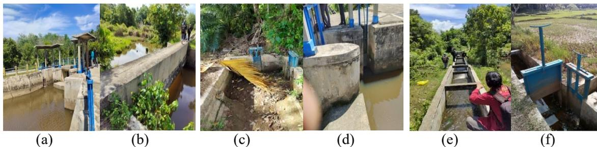
Gambar 2. Bangunan Irigasi : a. Bangunan Bendung, b, Talang, c. Bangunan Bagi, d. Bangunan Pengambilan (*intake*), e. Saluran Primer, f. Saluran Sekunder
