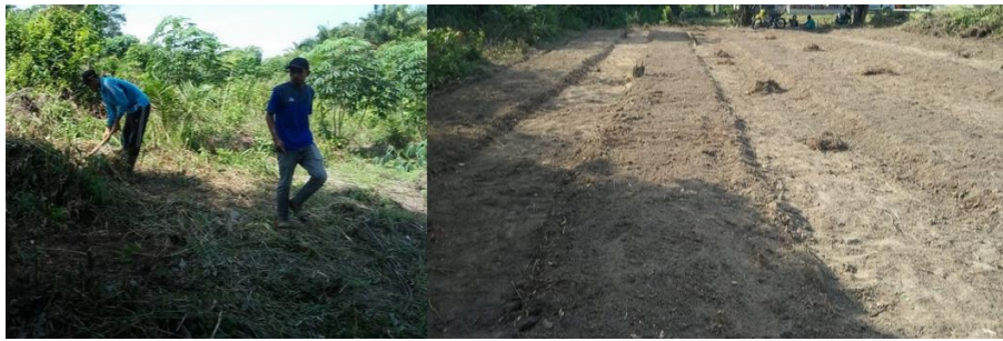
Gambar 4. Proses pematangan tanah pembuatan bedengan
