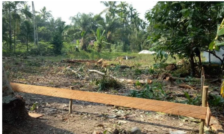
Gambar 1. Proses awal pembangunan sekolah
