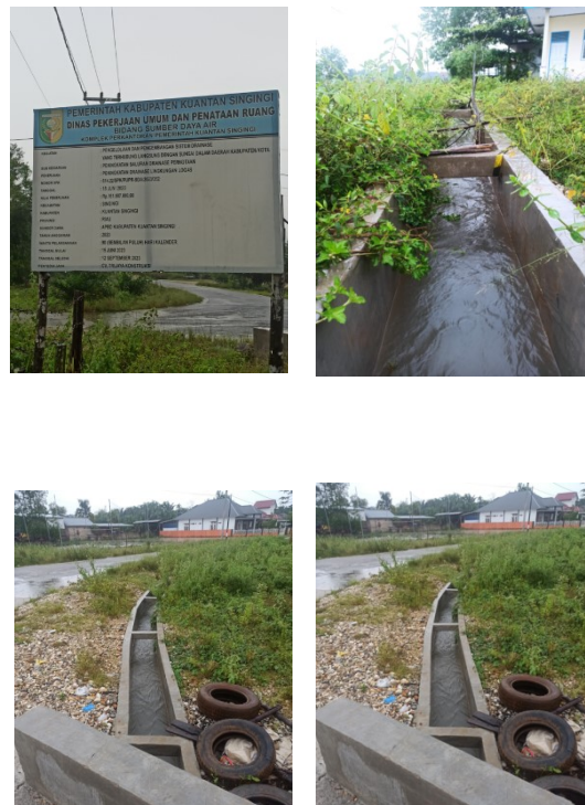
Gambar 2. Pembangunan Drainase yang merupakan Rekomendasi PkM Prodi TS
