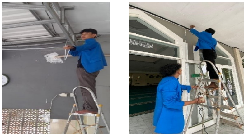
Gambar 4. (a) Instalasi Kabel, dan (b) Instalasi CCTV
