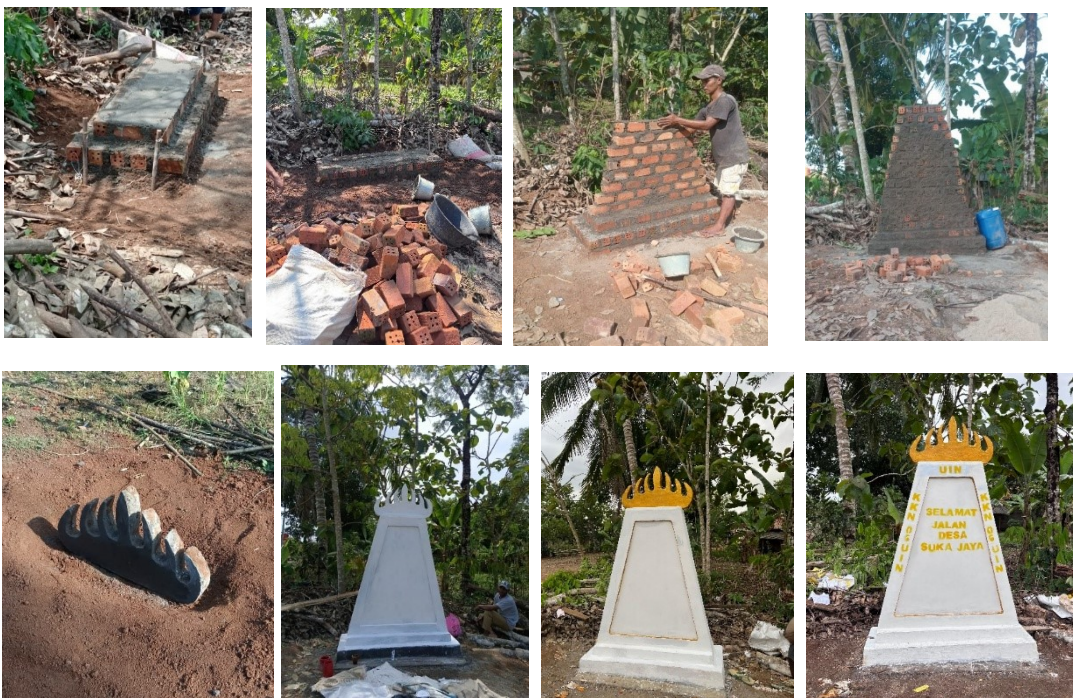
Gambar 1. Proses Pembuatan Tugu Perbatasan
