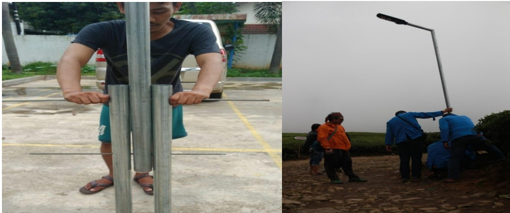
Gambar 3 Pemasangan Lampu Jalan
