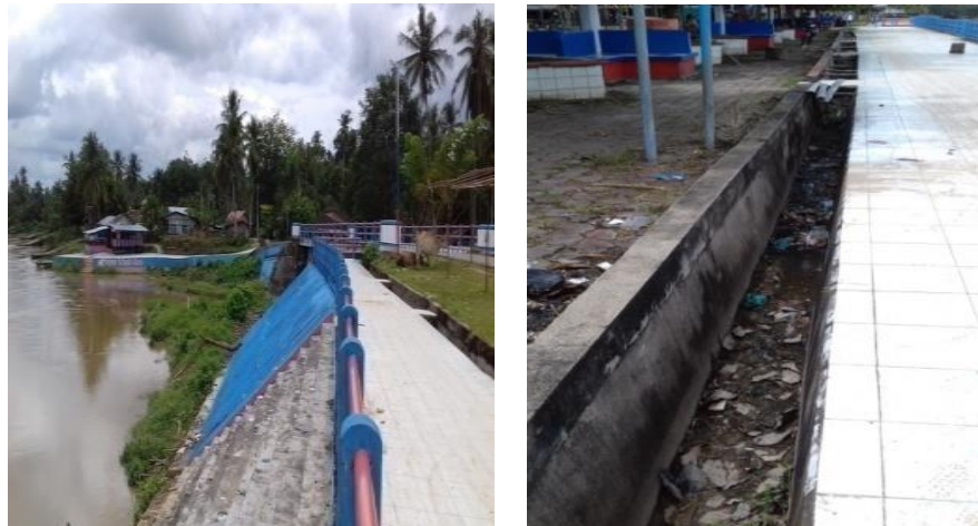
Gambar 10. Kondisi Tata Ruang Bangunan di DAS Kec. Kuantan Hilir
